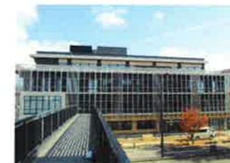
道路側歩道橋より
